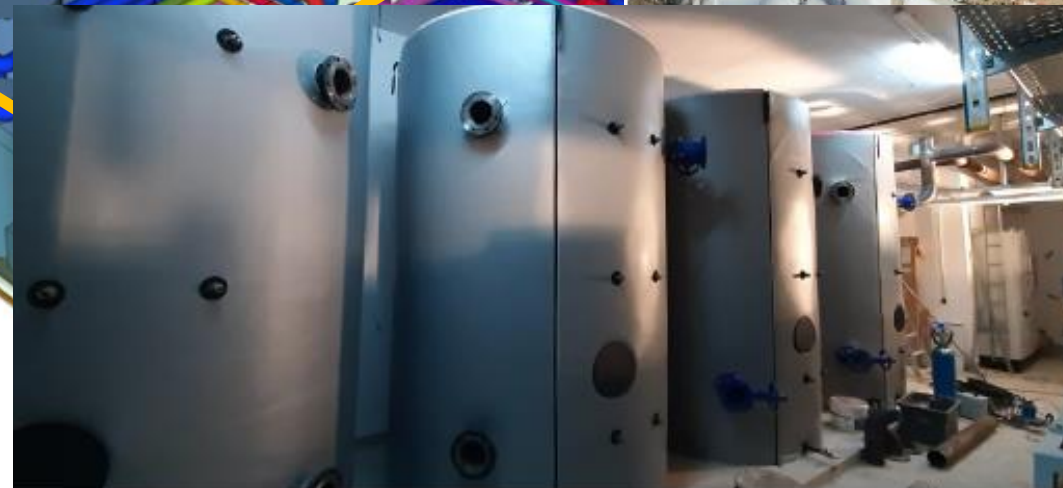
Wärmespeicher EZ © EGS-plan
